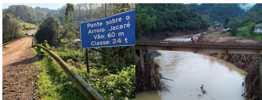
Figura 2.1: Ponte sobre o Arroio Jacaré com fluxo interrompido no Município de Relvado
