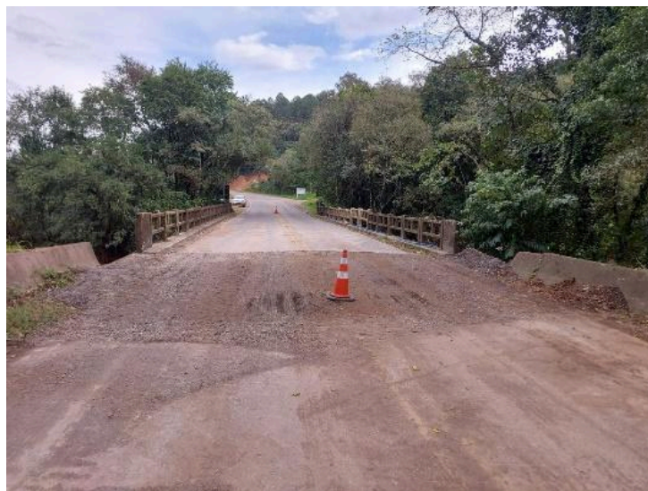
Figura 5: Cabeceira da Ponte sobre o Arroio Pinhal
