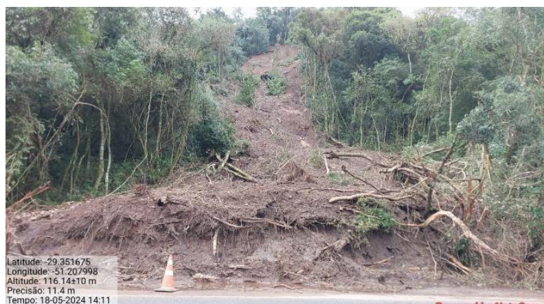
Figura 4: Deslizamento no km 21+770.
