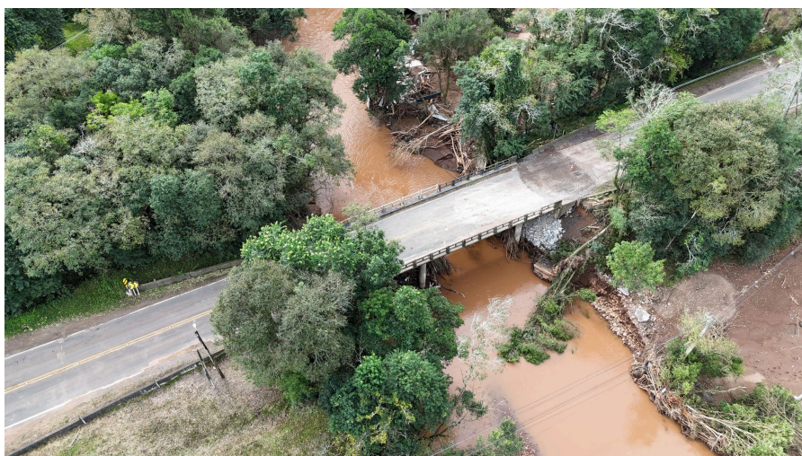
Figura 6: Ponte sobre o Arroio Pinhal
