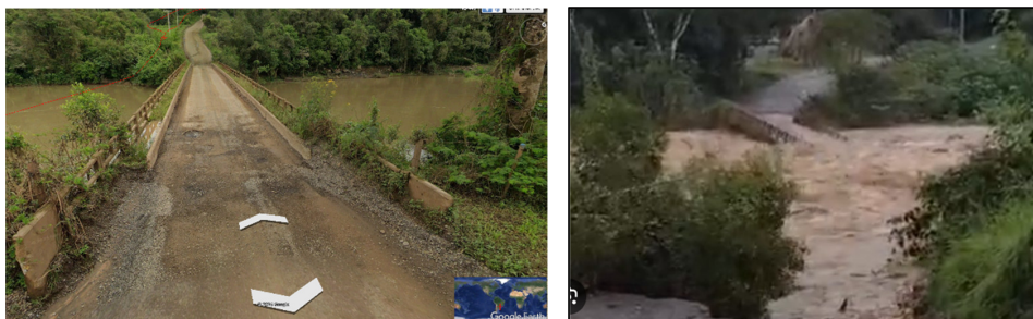
Figura 2.1: Ponte sobre o Arroio Não Sabia no Município de Vista Alegre do Prata
