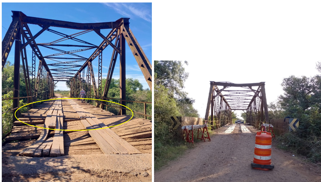
Fig. 4: Imagens da ponte de aço e madeira sobre o arroio Capivari, com capacidade de 24ton.
